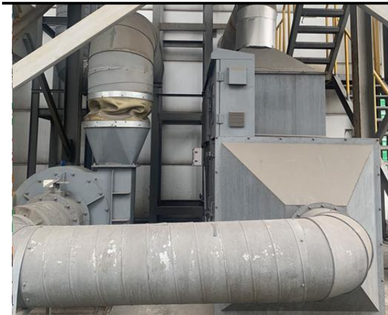
“初中效板式过滤器+静电吸附+UV光解+活性炭吸附”装置
