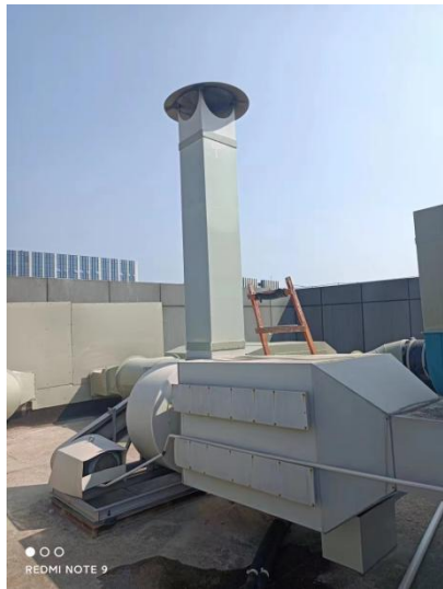
废气处理设施及排气筒
