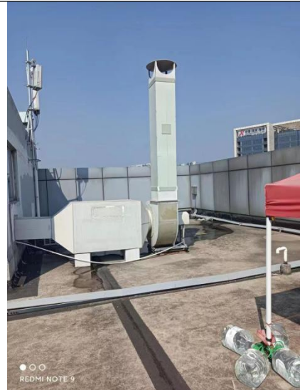
废气处理设施及排气筒
