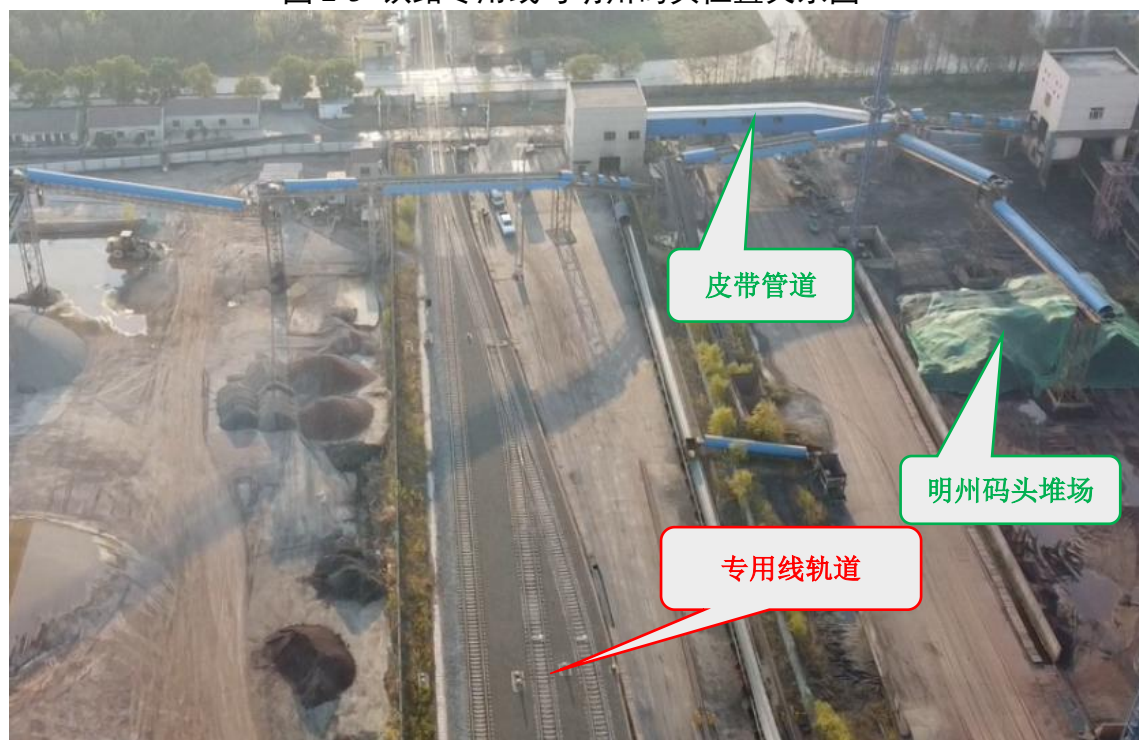
图 2-4 散货作业场明州码头所有皮带管道廊道现场照片图
