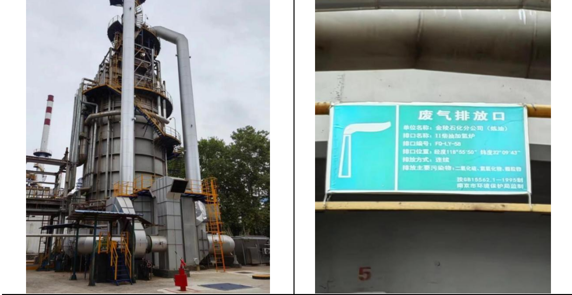
分馏塔底重沸炉 DA030 排气筒及标识牌
