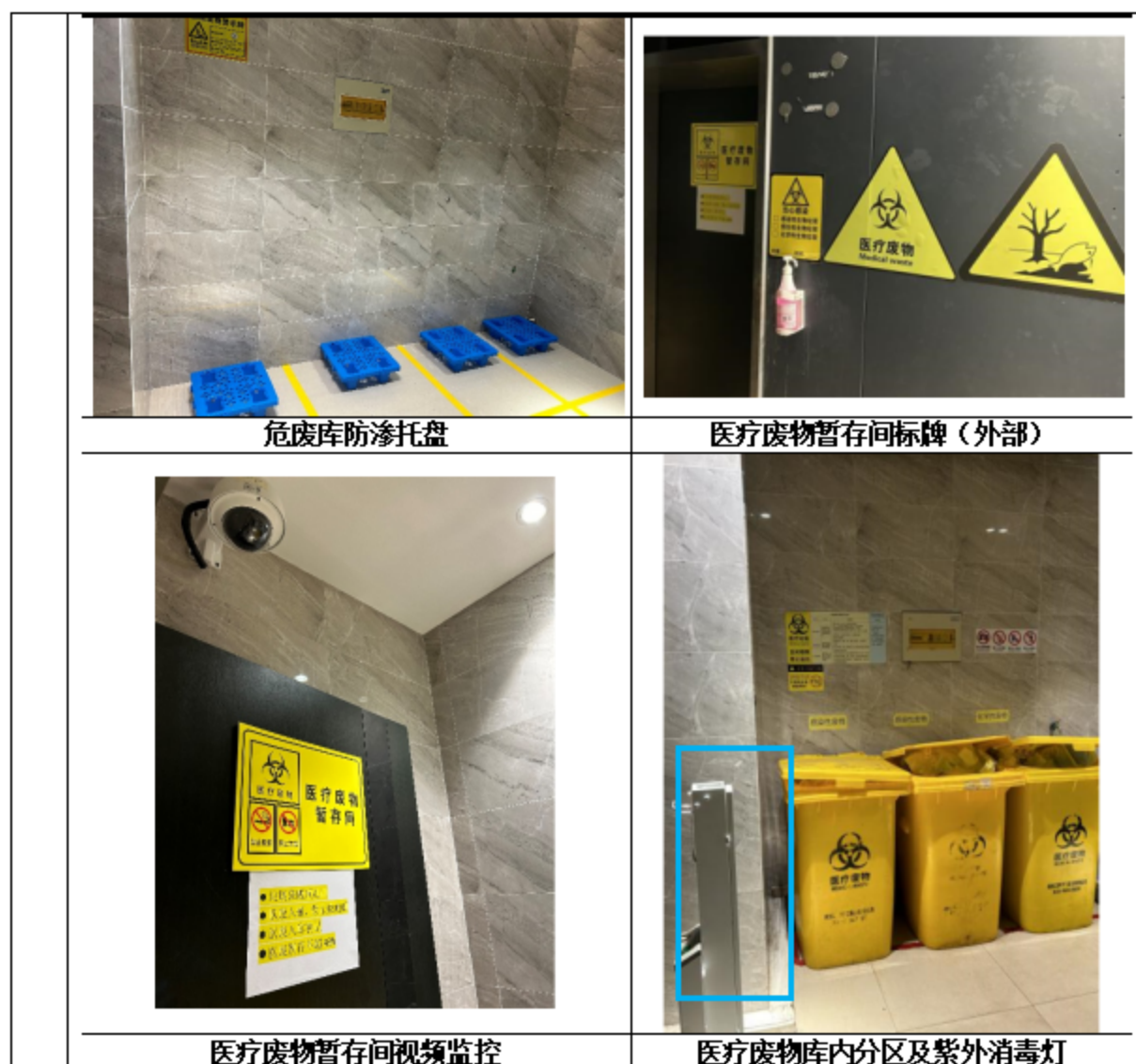
图 2-9 现有危险废物暂存间现场照片
