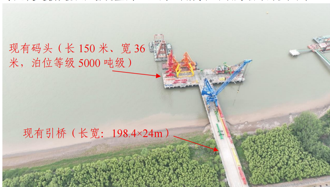
图 3.1.3-1 现有工程码头现场航拍图
