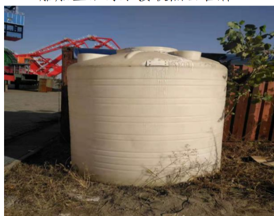
船舶生活污水转存储罐（10m³）
