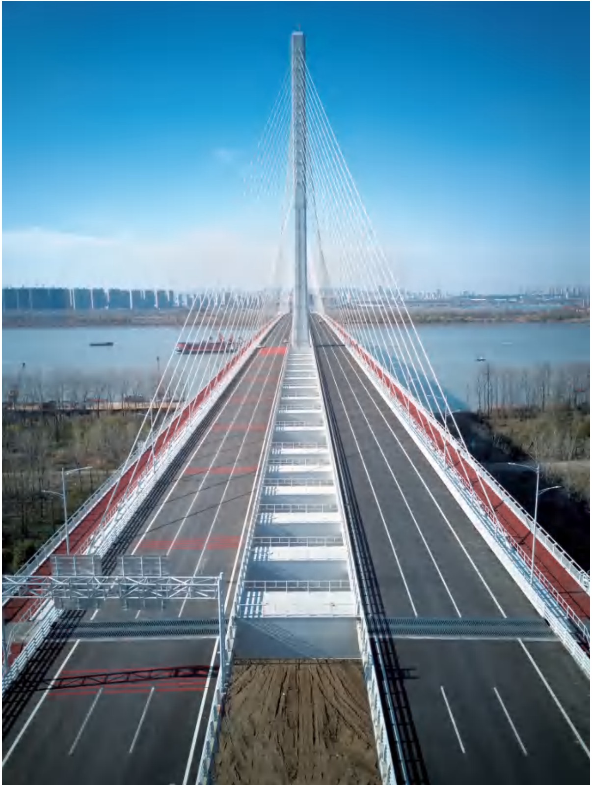
浦仪公路上坝夹江大桥
