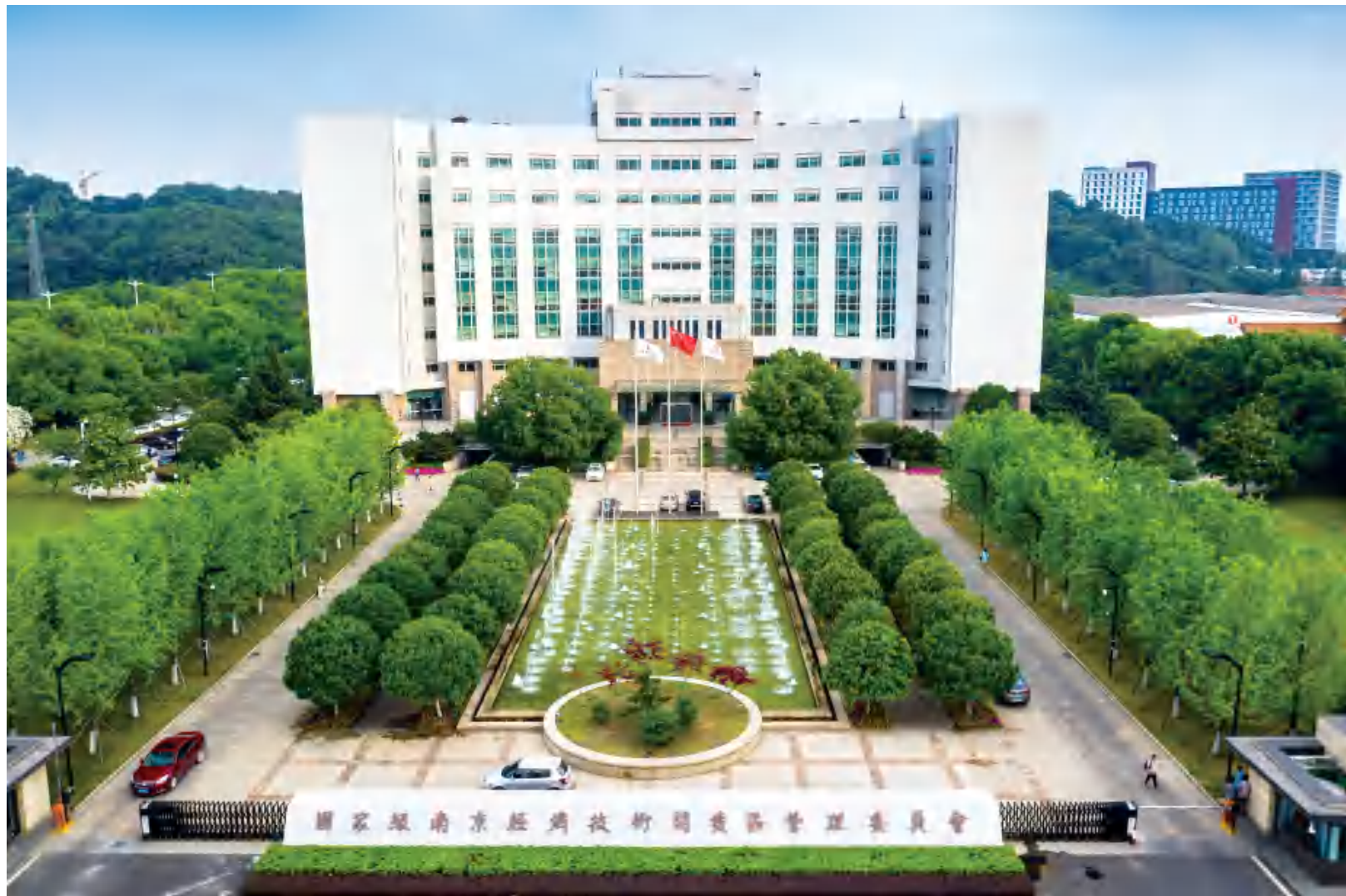
2020年南京经开区管委会大楼
