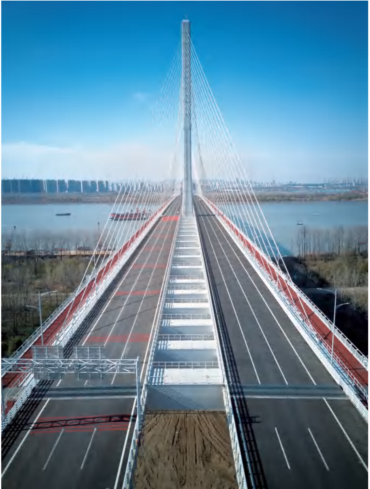
浦仪公路上坝夹江大桥
